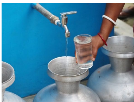
Photo 7 Soutirage de l'eau traitée
