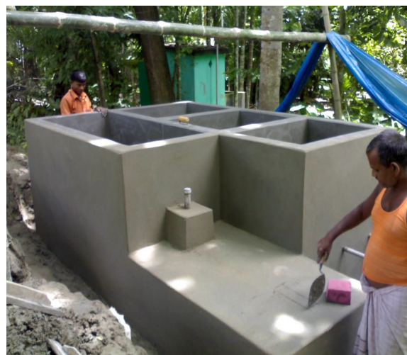
Photo 1 PSF en construction
