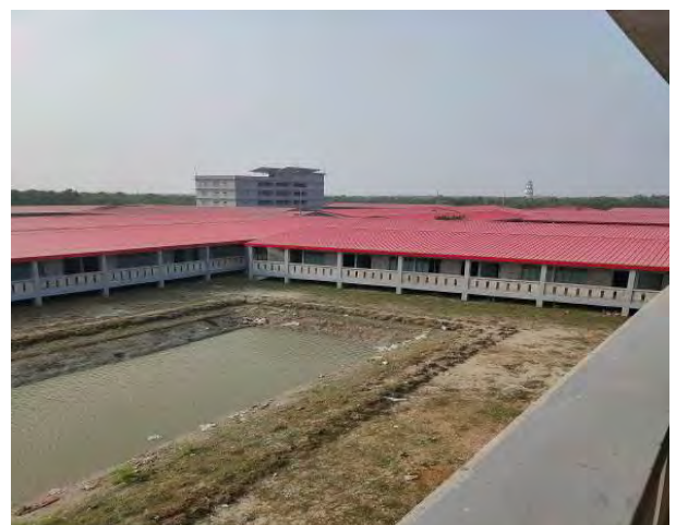
Vue partielle d'un bloc de 4 bâtiments sur pilotis composés de 16 pièces pour 16 familles de 4 personnes une mare au centre du bloc..
