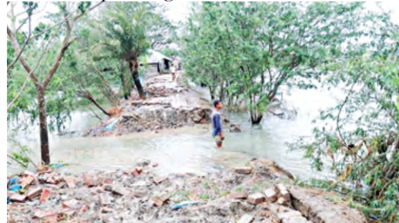
Brèche dans une digue dans la région côtière. Le cyclone Amphan a détruit plus de 200.000 maisons, 180.000 ha de récoltes et déplacé temporairement un million de gens. © Daily Star
